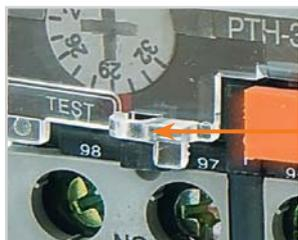
Пломбирование прозрачной крышки, защищающей диск регулировки тока срабатывания, исключает несанкционированный доступ к нему.
