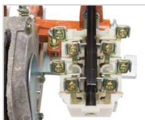
Дополнительные контакты 2з+2р для удобного подключения цепей внешней коммутации.
