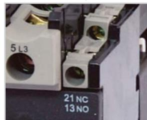
Контакторы на ток нагрузки до 40 А имеют один дополнительный контакт (закрывающий или размыкающий), контакторы на ток нагрузки свыше 40 А имеют два дополнительных контакта (закрывающий и размыкающий).
