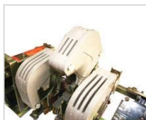
Конструкция крышек дугогасительных камер обеспечивает свободный доступ к силовым контактам.
