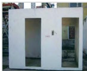
Размеры монтажной коробки блоков БКВР позволяют без дополнительных усилий устанавливать блоки в гнезда типовых сантехкабин.
