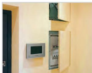
Для доступа к инженерным коммуникациям и элементам управления сантехнических и электрических систем.
