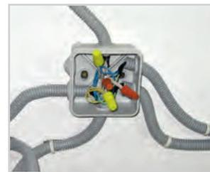
Коробки предназначены для крепления на стены, потолки. Могут использоваться как отдельно, так и в системе с трубами из ПВХ или металлопрокатом.
