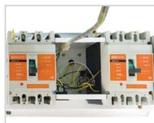
Использование в БАВР автоматических выключателей позволяет не только переключать вводы, но и обеспечивать защиту линий от перегрузок и токов КЗ с последующим переводом устройства в режим "АВАРИЯ".
