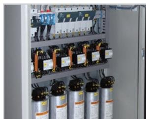
В установках компенсации реактивной мощности в сетях 0,4 кВ и частотой 50 Гц.
