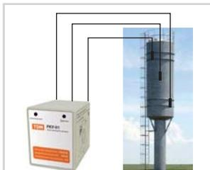
Автоматический контроль уровня воды в водонапорной башне.
